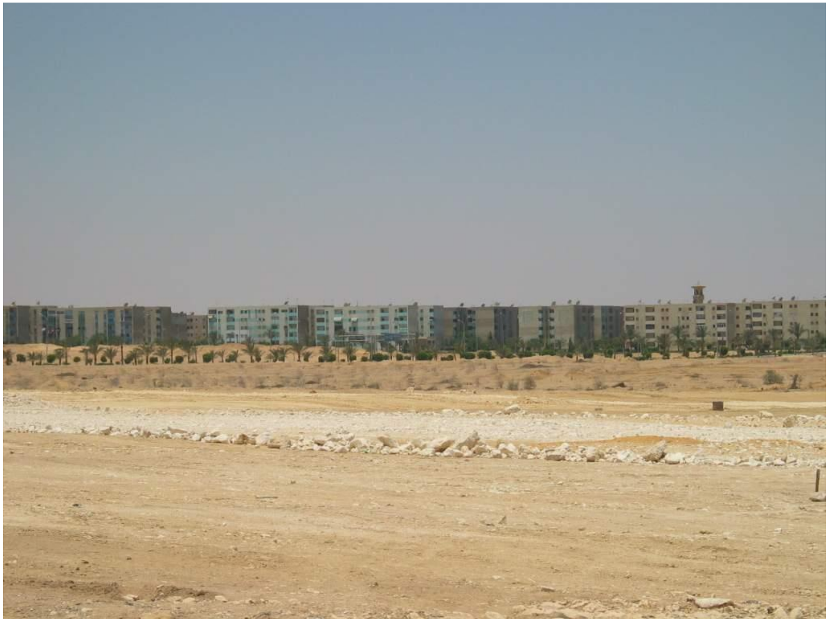
Un changement d'échelle urbaine : Cheikh el-Zayed (habitat collectif)
